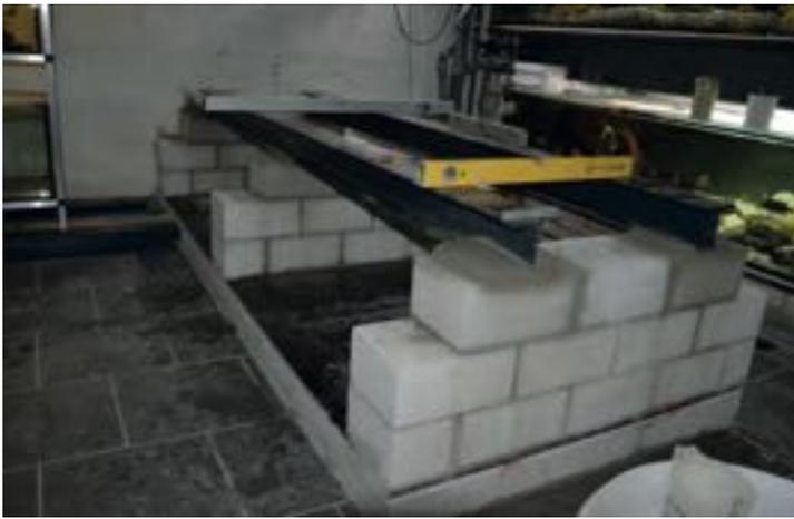
Drei Säulen sind aufgemauert, und die Doppel-T-Träger werden auf Mörtel genau ausbalanciert.
