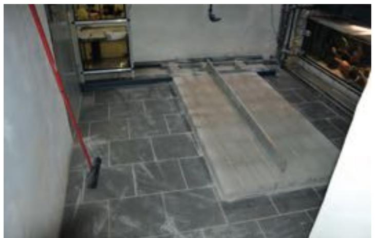
Das Fundament aus KS-Steinen ist fertig.
